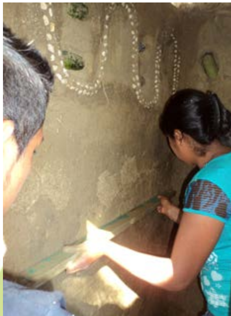
Alumna de secundaria repellando un muro de la letrina compostera.
