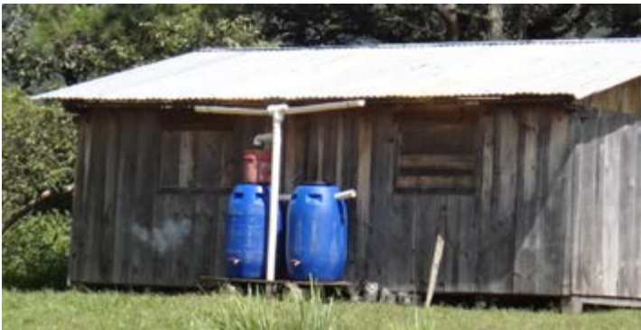
Sistema de captación de agua de lluvia en la comunidad de Belén.
