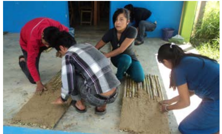
Construcción de paneles para aislamiento de techos.
